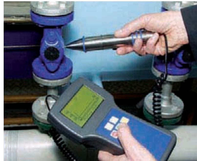
▲ Helmut Früh, Technischer Dienst Mühlberger, bei der Kondensatableiterprüfung.
